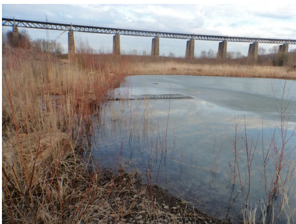
Viaduc avec mare compensatoire en premier plan
