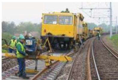
Longs Rails soudés sur traverses béton
